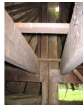
staalkabel bevestigd aan kruishout
